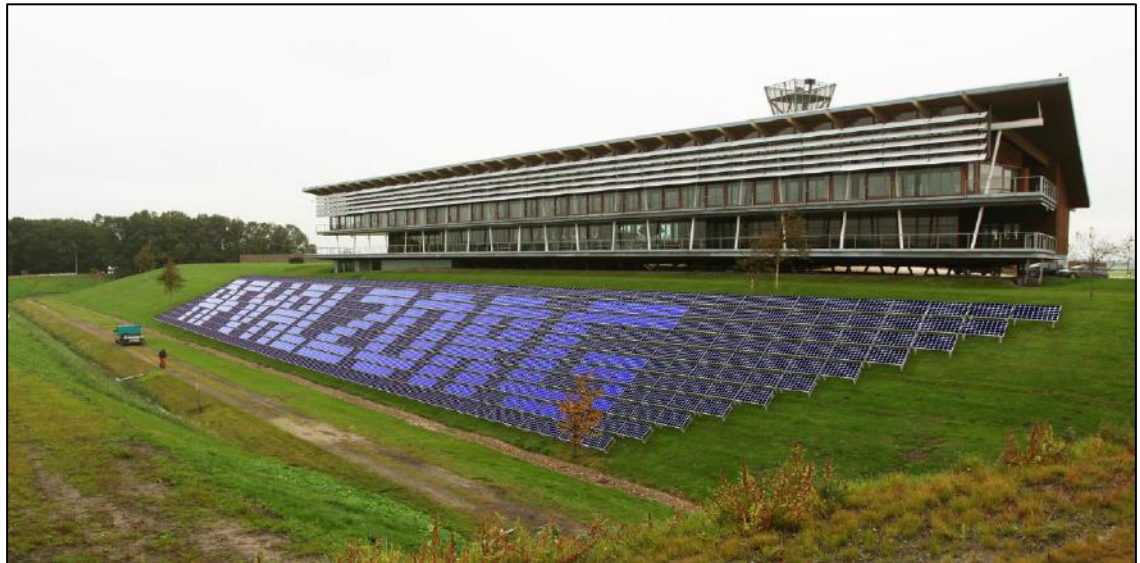
figuur 10 Projectie van zonnepanelen op zuid talud stortlocatie Nauerna
